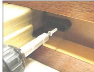
Prendere il cassonetto superiore ( n.1 ), inserirlo nella predisposizione in alto del serramento e fissarlo con idonee viti alle spallette del muro per mezzo delle testate laterali (n.3)
